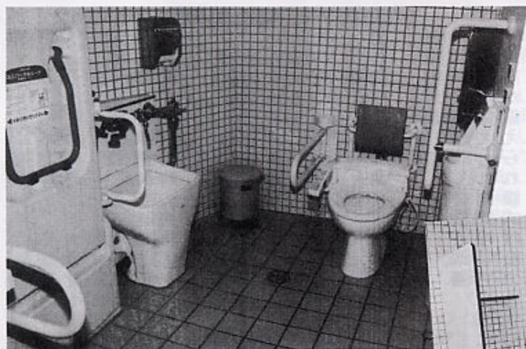
車いす用トイレ
